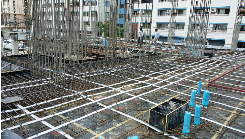
รูปภาพ เหล็กเสริมรอบผนังลิฟท์
